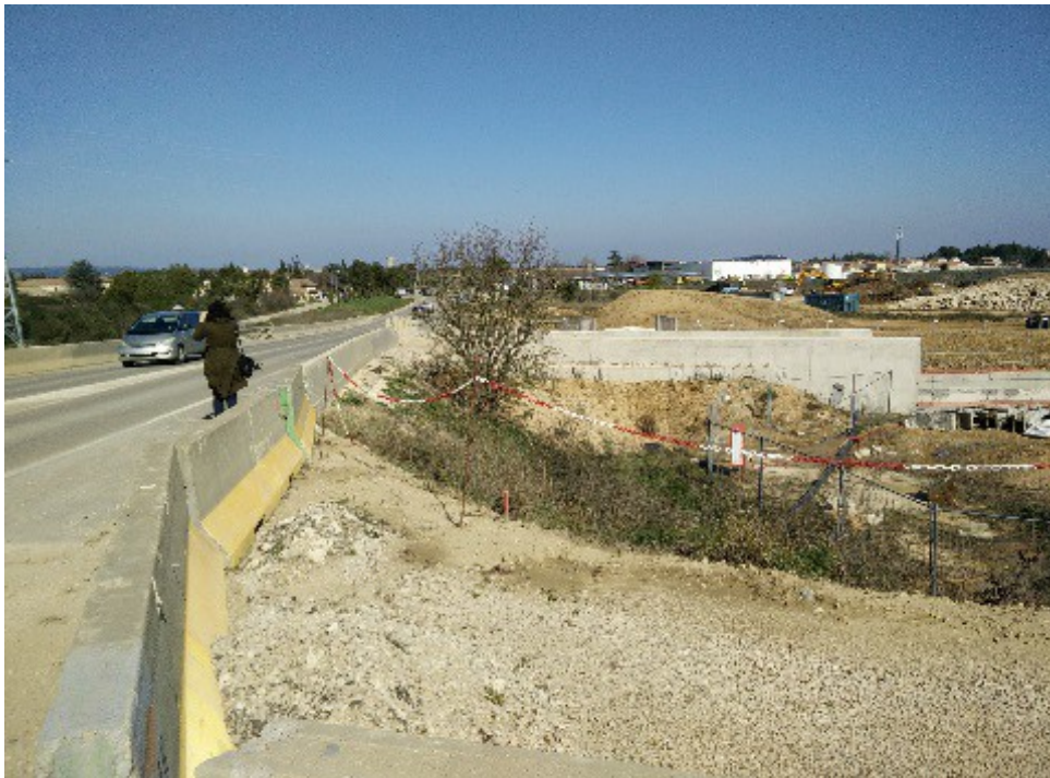
Photo ouvrage CNM côté sud-est
